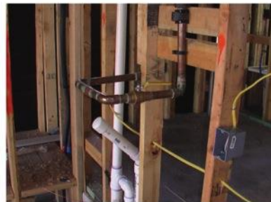
(D) NONMETALLIC-SHEATHED CABLE
